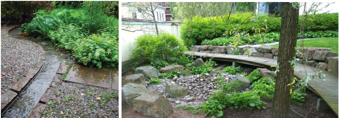
Kuva 11. Hulevedet ohjaaminen kourulla kasvillisuudelle (vas.) ja esimerkkikuva kivipintaisesta imeytyspainanteesta (oik.).
