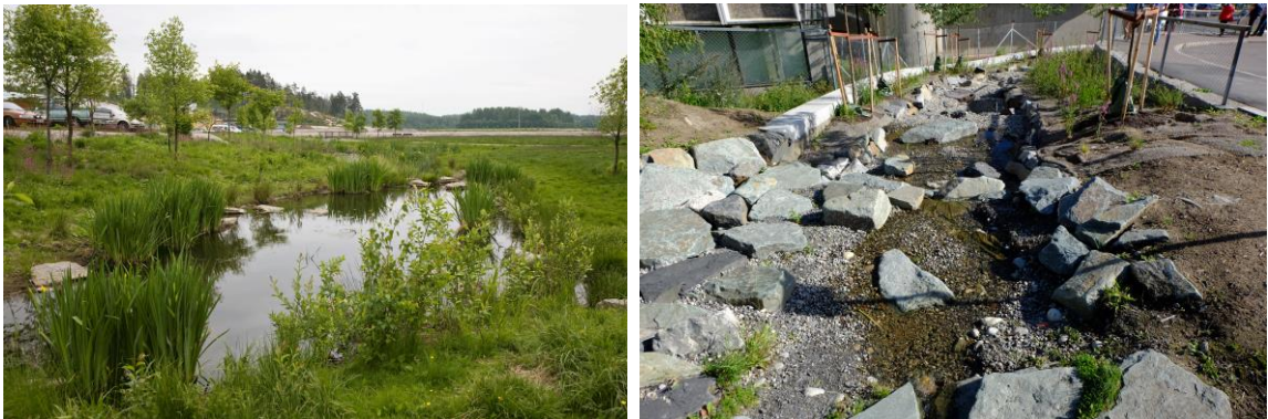
Kuva 6. Yleisten alueiden hulevesirakenteet toteutetaan luontopohjaisina ja maastoon sopivina. Louhinnasta muodostuvia kiviä voidaan hyödyntää ympäristörakentamisen lisäksi myös hulevesirakenteissa.
