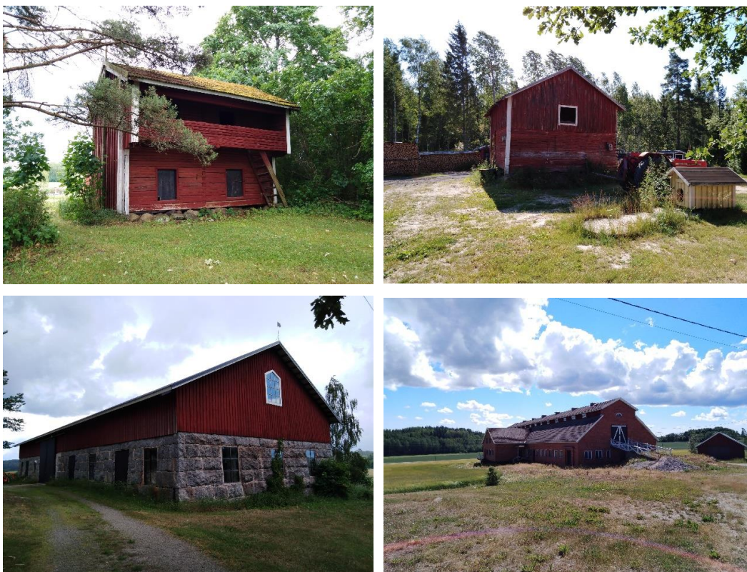
Kuva 13. Korpisin hirsiluhti, Högbackan hirsiaitta, Grönkullan lohkokivinavetta ja Kockisin tiilinavetta
